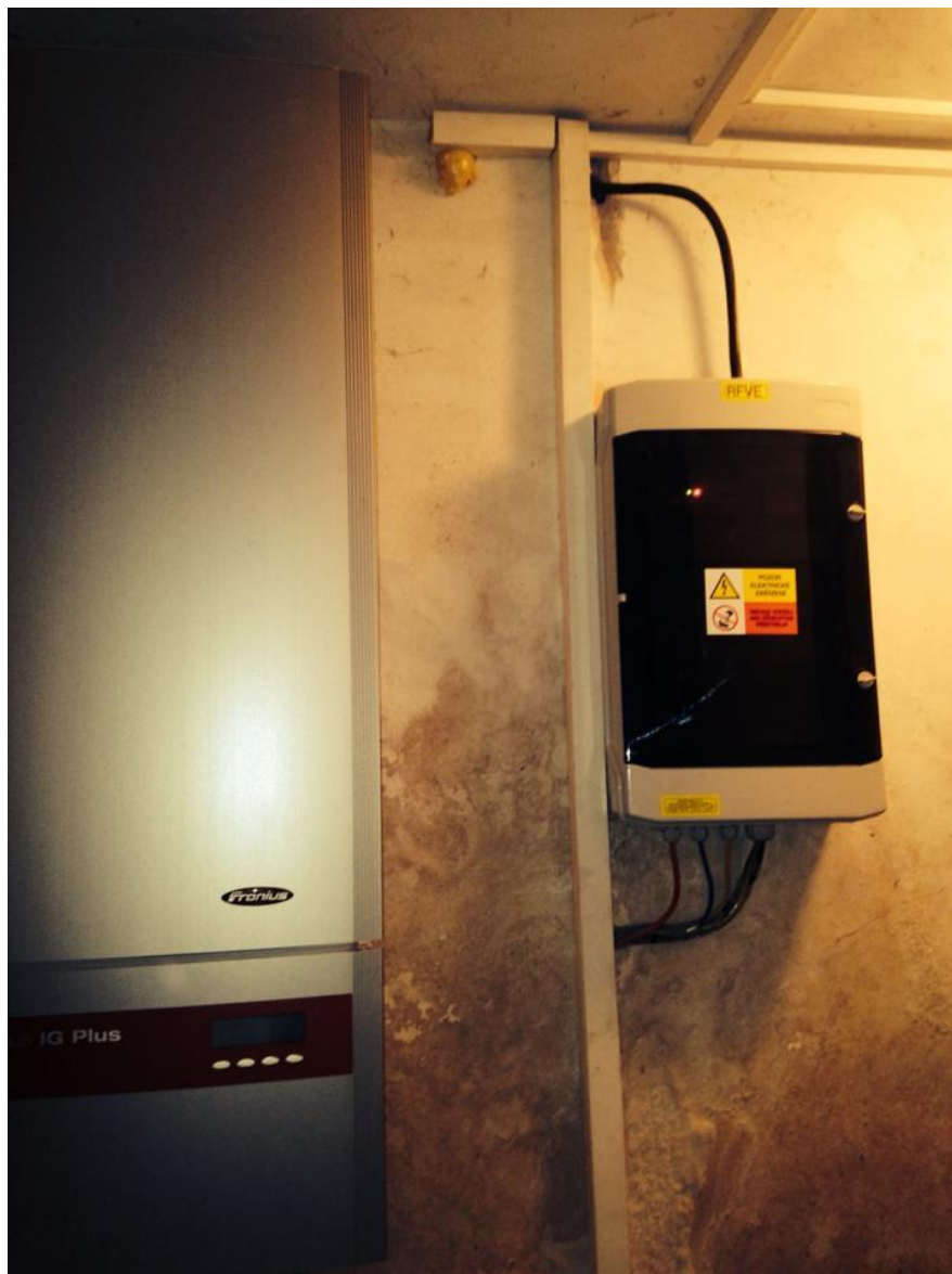
Obr. 2 - měniče stejnosměrného proudu na střídavý
